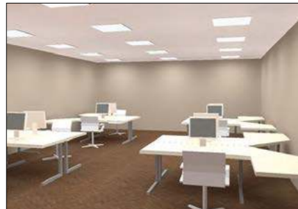
Рис. 2 Офис, освещение с помощью прибора PRS/R ECO LED, расставленный полем UGR < 10, E ср = 417 лк, удельной мощности 9,2 Вт/м 2
