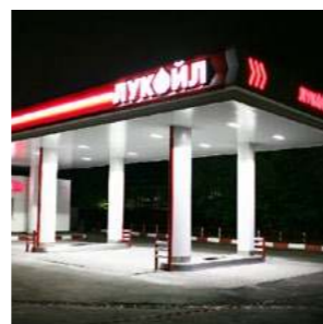
Автозаправочная станция г. Волгоград 2011
